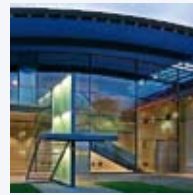
D Neues Foyer
