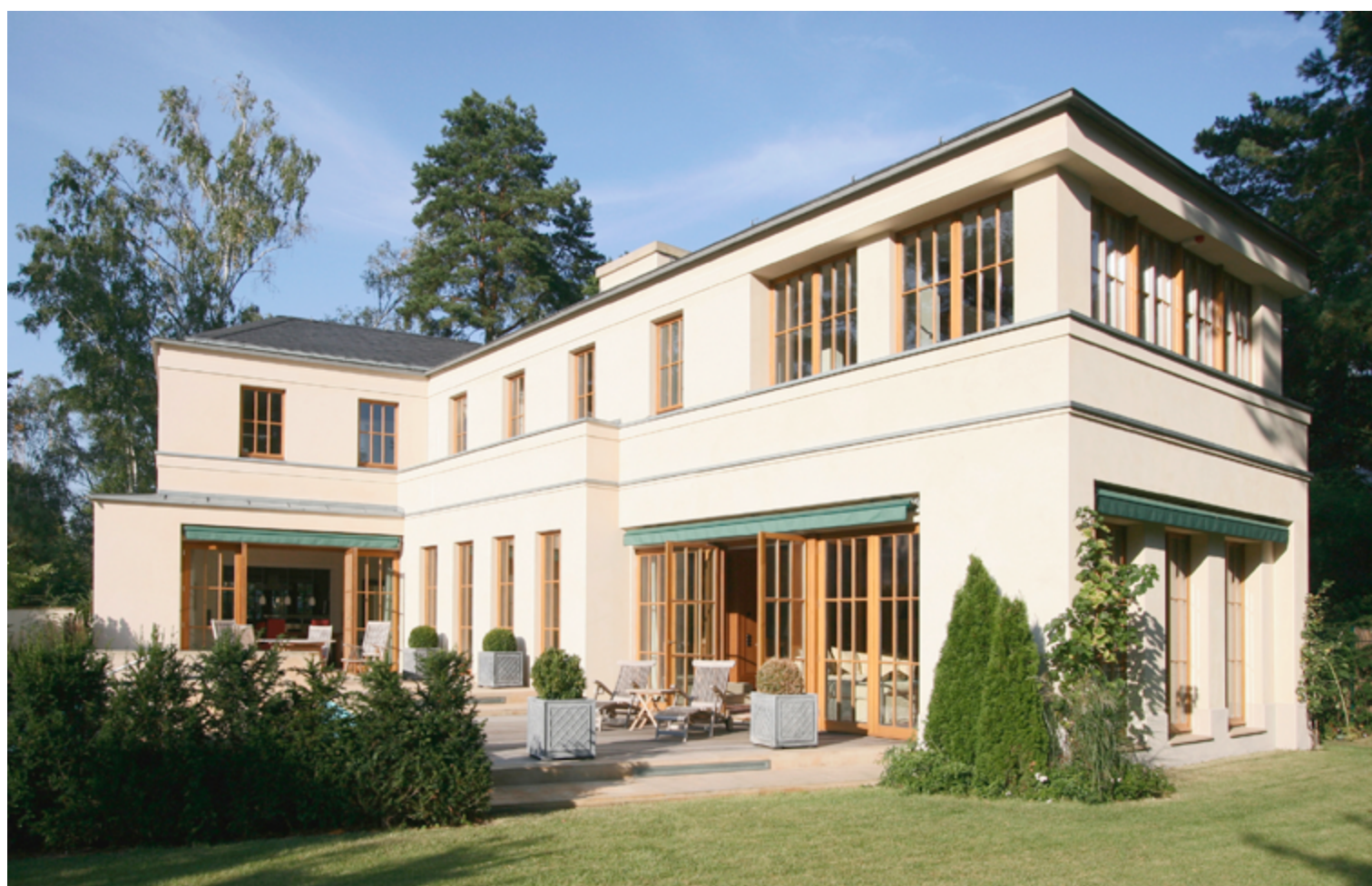
Il giardino privato a sud-ovest con l'impianto a terrazzamenti. In basso a destra: planimetria del piano terra con la sistemazione esterna. Der Privatgarten im Südwesten mit Terrassenanlagen. Unten rechts: Grundriss Erd geschoss im Lageplan.
